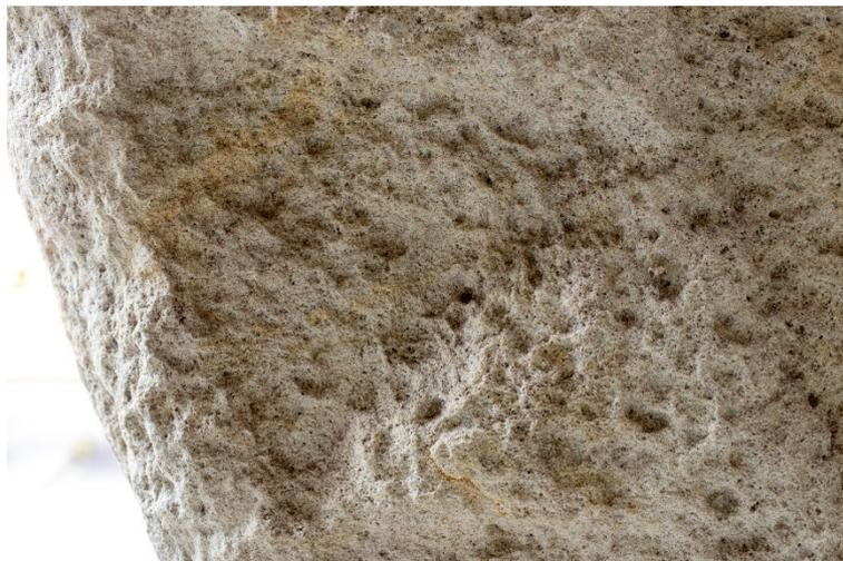
97 Desgaste de la cara trasera de Barros I. Muestra de la erosión de la superficie por la acción directa del viento y la lluvia.
